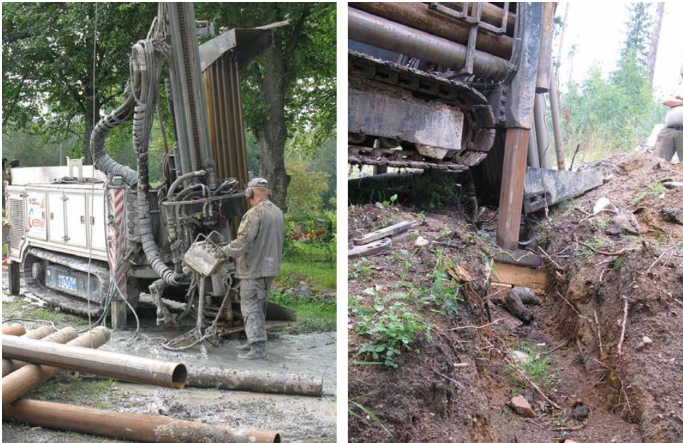
Kuva 12. Porauksen valmistelu on helpompaa, kun kaivutyöt tehdään porauksen jälkeen. (Kuvat: Janne Juvonen)
