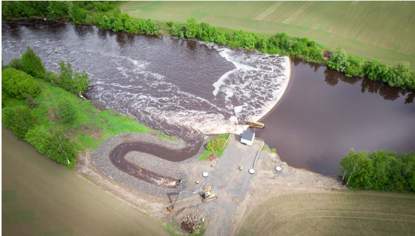
Kalatie rakennettiin, jotta vaelluskalat pääsevät yläjuoksuun pohjapadon ohi.
