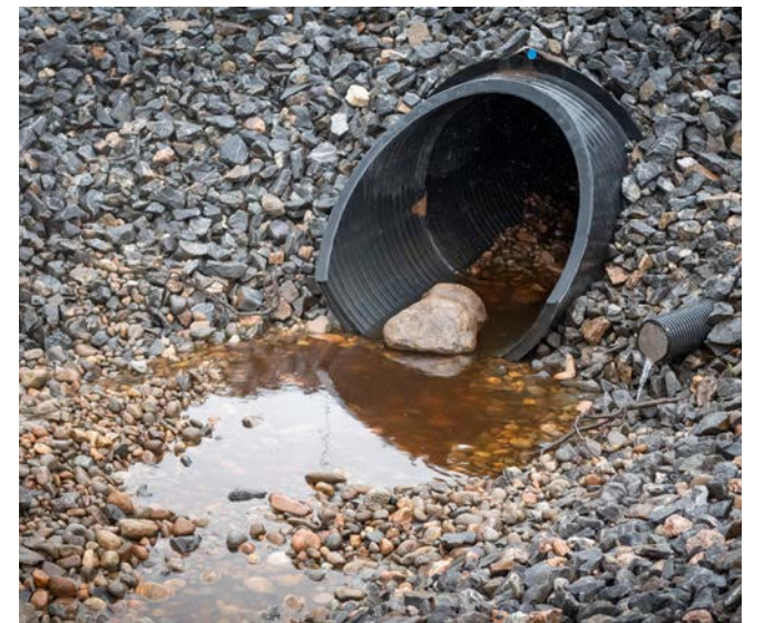
Kalatien putkena käytettiin halkaisijaltaan 1600 millin kierresaumaputkea.
