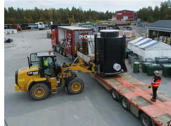
Kohteeseen toimitettiin 24 laitekaivoa.
