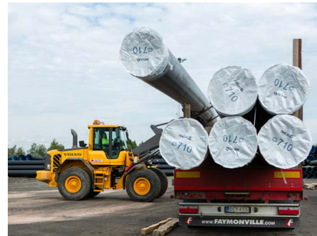
Kohteeseen toimitettiin 20 kilometriä Ø710 PE-paineputkea.
