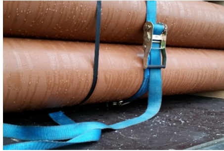
Huomioi kiristettäessä, että liina ei puris- ta putkeen painaamaa.
